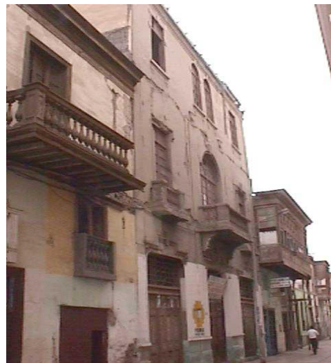
Fachada de la futura sala de teatro “Adrián Marcelo Montalván Garcés”
