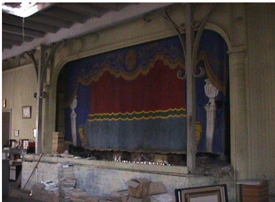
Interior de la sala de teatro. Se puede notar las columnas de hierro sostenido el techo
