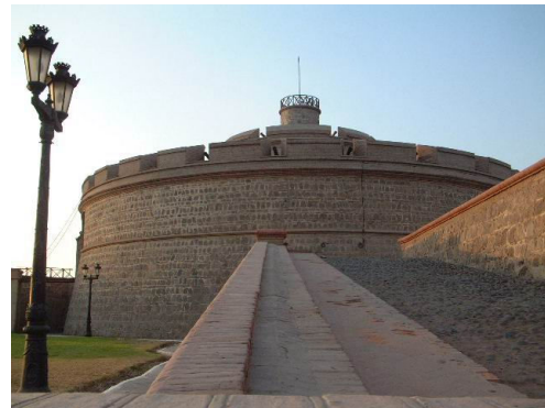
Rampa de acceso al torreón del Rey
